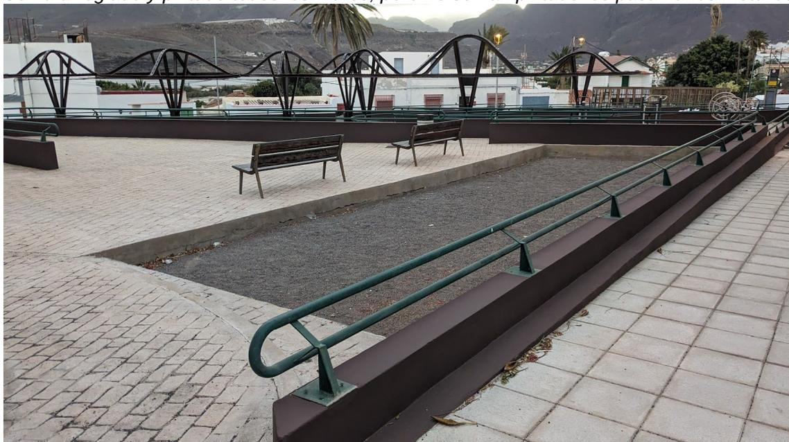
Las traviesas metálicas que se han colocado para recibir la pérgola de madera se están oxidando. Antes de colocar los listones de madera se debería pintar dichas traviesas con imprimación antioxidante para evitar manchar los listones.
